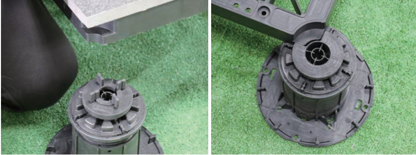
SGロック解除部へグリッドを設置した状況
